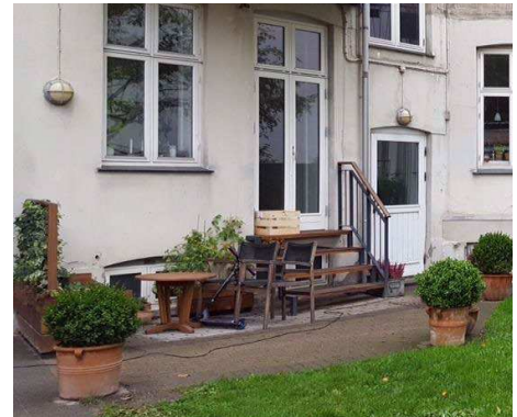
Trappe til terræn etableret vinkelret på facaden.
